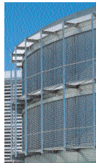
Motorisierung moderner Architektur
